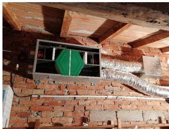
Foto di cantiere
