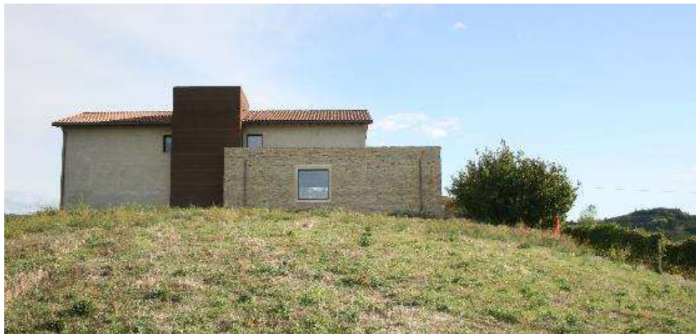
Isolamento di copertura – Casa Attiva – Trezzo Tinella (CN)
