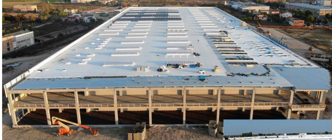
Sistema Copertura certificato Factory Mutual Polo logistico Teddy – Gatteo (FC)
