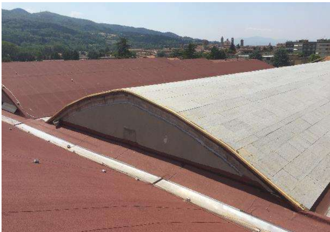
Isolamento di copertura curva- Museo Burri – Città di Castello (PG)
