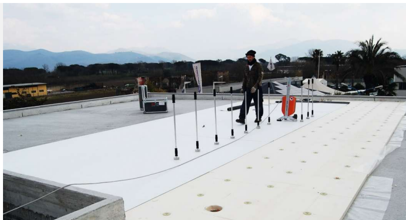
Cool Roof - Membrane sintetiche e fissaggio a induzione Struttura commerciale - San Vitaliano (NA)
