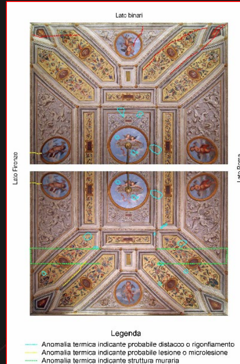
Fotopiano volta in visibile con indicazione anomalie termiche
