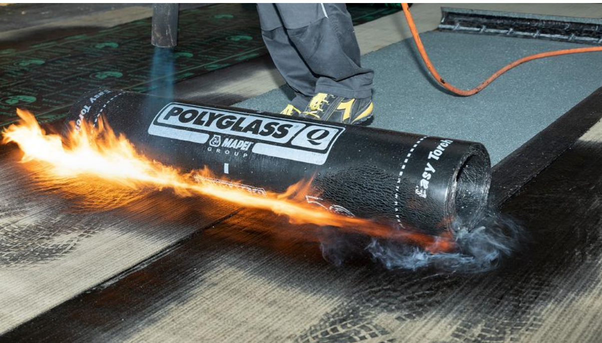
Applicazione a fiamma Membrane tradizionali
