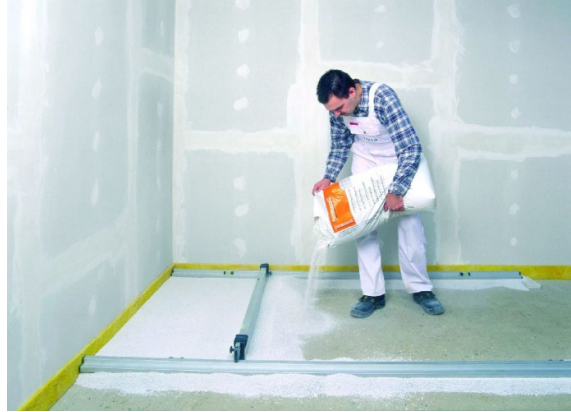
Livellante granulare leggero
