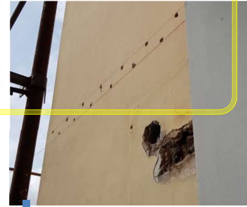
Preparazione dei fori e inghisaggio delle barre
