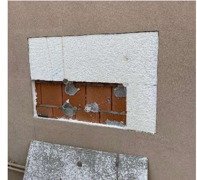
Verifica vecchio cappotto
