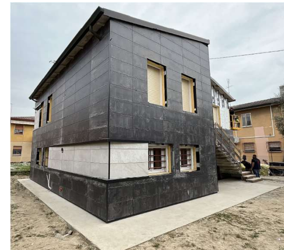
Facciata a secco rivestimento ceramico Wall Evo – Edif. Civile (Padova)
