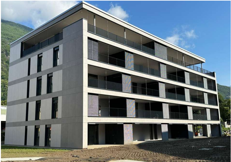
Facciata a secco rivestimento ceramico Wall Evo – Condominio – Lugano (Svizzera)
