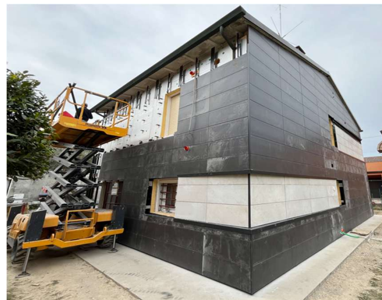
Facciata a secco rivestimento ceramico Wall Evo – Edif. Civile (Padova)
