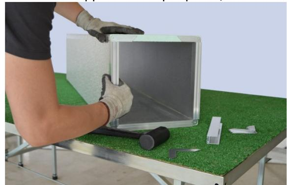
Applicare, infine, il silicone lungo gli spigoli interni del canale.
