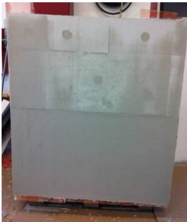
*Durante l'asciugatura del rasante posato nello stesso periodo la parte bassa con una rasatura armata eseguita correttamente asciuga uniformemente a differenza della parte alta*
