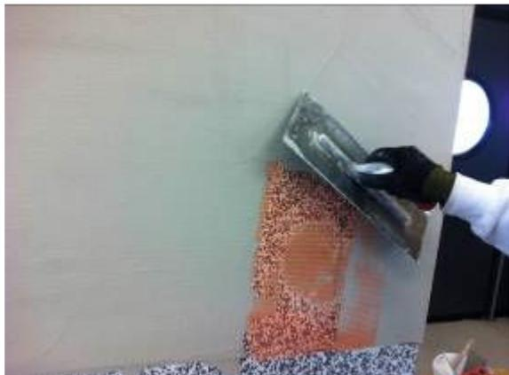
*Dettaglio della parte alta con l'errore di posa nella rasatura della rete: si appoggia la rete e si rassa*
