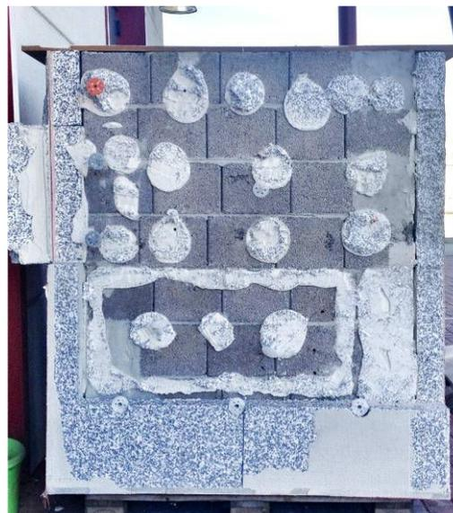
*Rimosso il rivestimento e il sistema a cappotto nella parte alta è presente il sistema di incollaggio non corretto per punti, nella parte bassa il sistema di incollaggio corretto con cordolo e tre punti all'interno*
