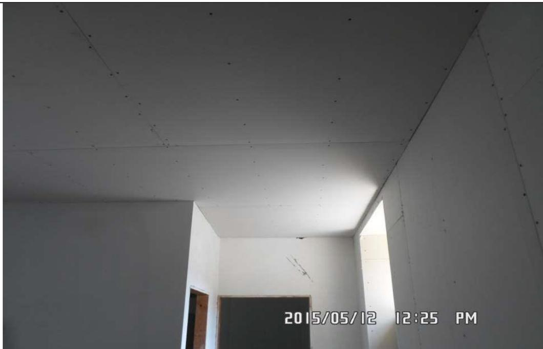
Isolamento pareti verticali W626 GKB+B.V. e KASA e prima fase di lavorazione controsoffitti ad orditura autoportante D117
