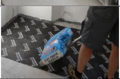
È necessario, una volta steso il materiale resiliente, utilizzare un rullo da resilienti per garantire una perfetta adesione del materassino allo strato di colla.
