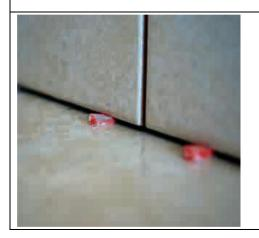
Il battiscopa ceramico deve essere slegato dal pavimento (pochi mm) e fugato con un legante elastico a base siliconica o con una malta additivata a componente flessibile.
