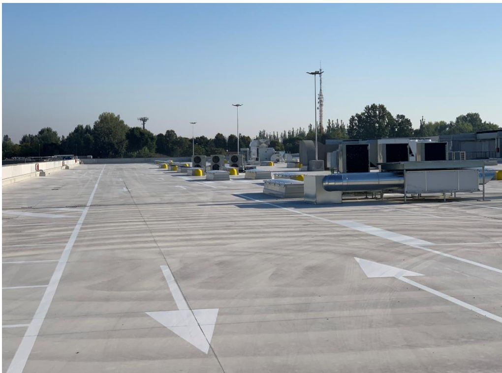
Esempio di copertura carrabile con parcheggio realizzata con lastre in polistirene estruso X-FOAM HBT 500
