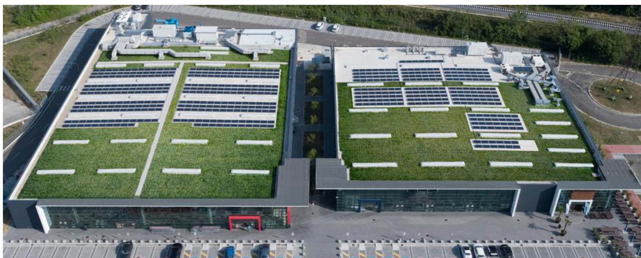
Esempio di copertura di un centro commerciale: tetto caldo giardino isolato con pannelli in poliuretano espanso POLIISO PLUS
