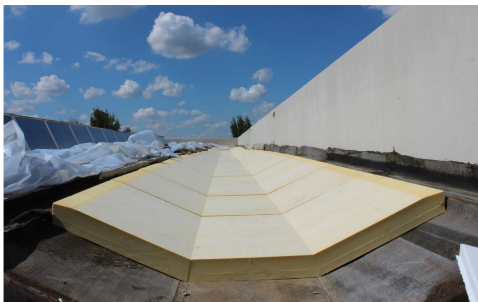
Isolamento copertura industriale con POLIISO su misura
