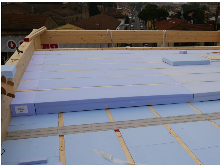
Posa in copertura dei pannelli pendenzati X-FOAM
