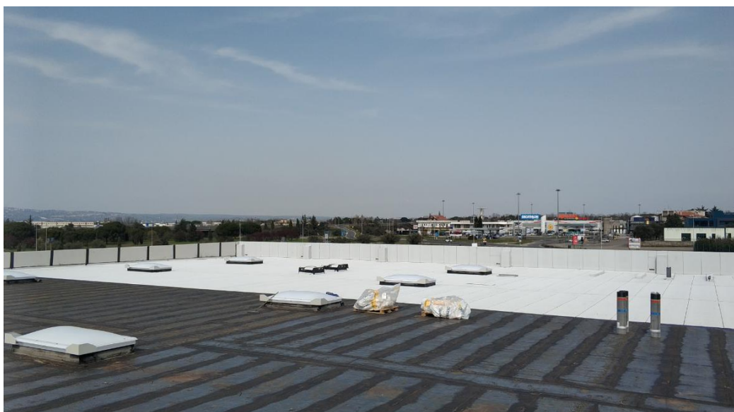
Esempio di tetto caldo isolato con pannello in poliuretano espanso POLIISO SB
