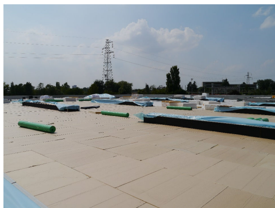
Esempio di tetto caldo con POLIISO PLUS
